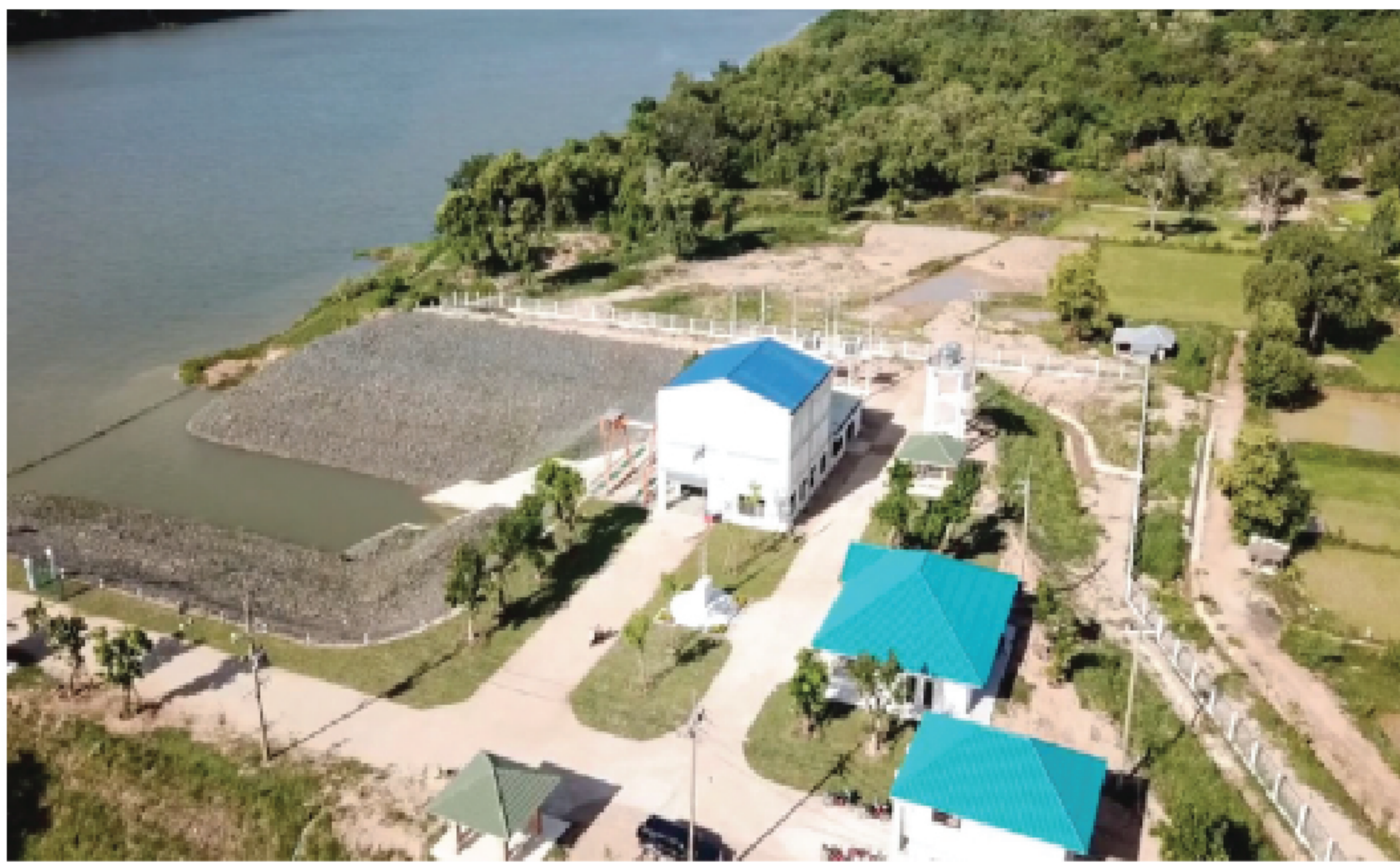
สถานีสูบน้ำด้วยไฟฟ้า PL-5
